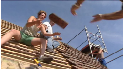
Sur le toit de l'habitat, jeunes architectes et bacheliers de la première année travaillent main dans la main.
